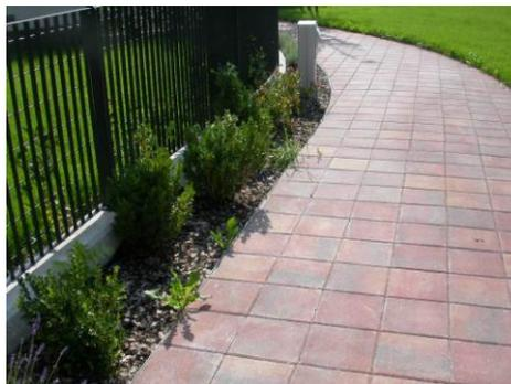
esempio di pavimentazione in formelle cls
