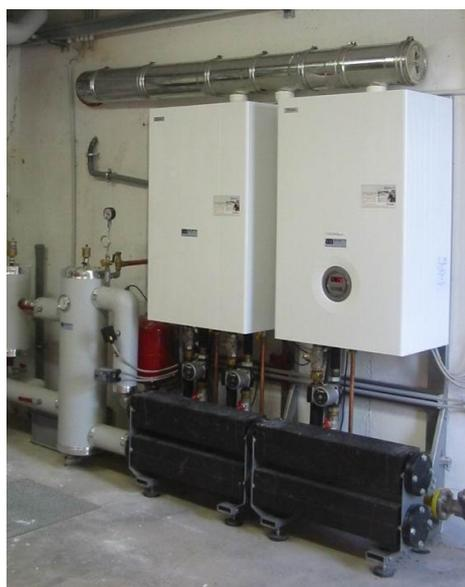
caldaia del tipo modulante a gas metano
