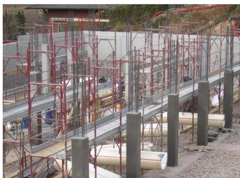
interrato con muri perimetrali e pilastri in c.a.
