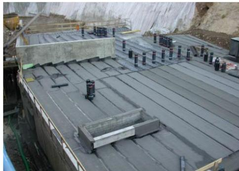
impermeabilizzazione solaio piano interrato
