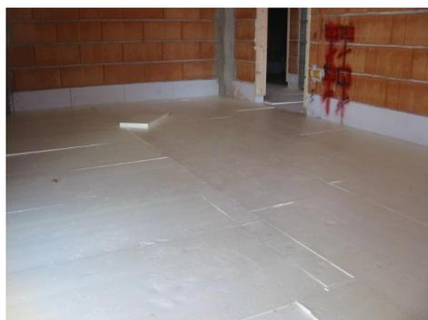
isolamento termico estradosso solaio
