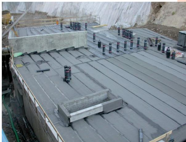
*impermeabilizzazione solaio interrato*
