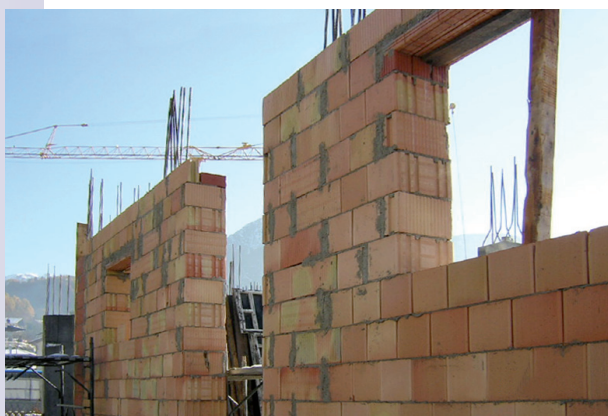
murature portanti in blocchi di laterizio alveolare
