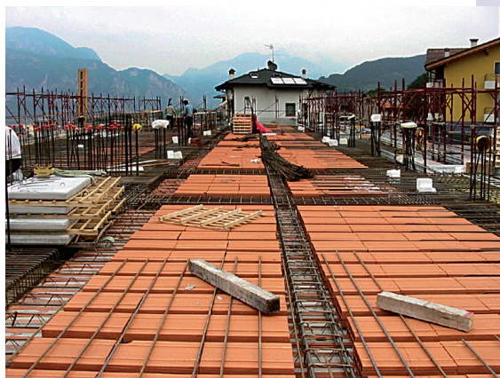
solai tipo Bausta in laterocemento
