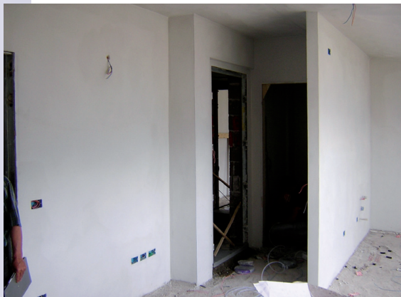
intonaci interni appartamenti e vano scale
