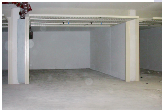
tinteggiatura piano interrato
