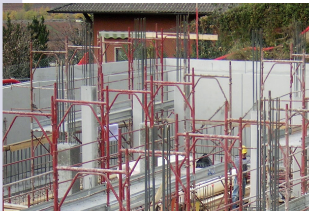
pilastri e murature perimetrali entro terra
