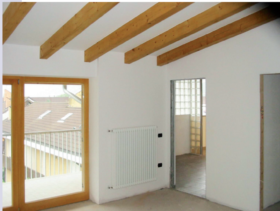
struttura portante secondaria e riv. interno
