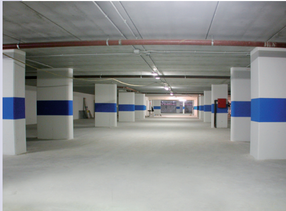
murature in cls e solaio interrato
