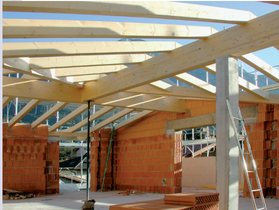
struttura portante primaria
