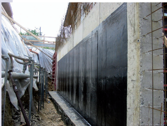
impermeabilizzazione murature interrate
