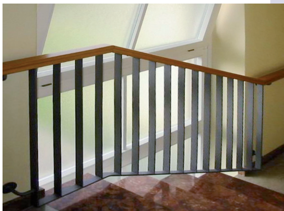
parapetti interni scale
