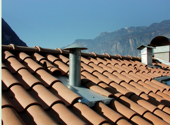
manto di copertura in coppi
