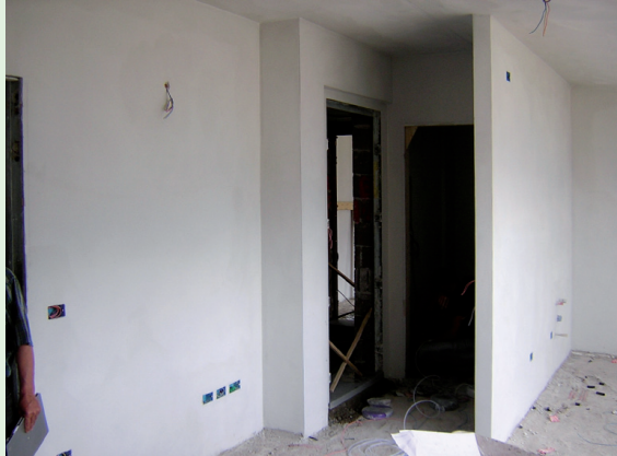
intonaci interni appartamenti
