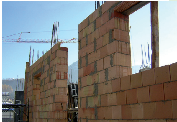
murature perimetrali in blocchi tipo Poroton
