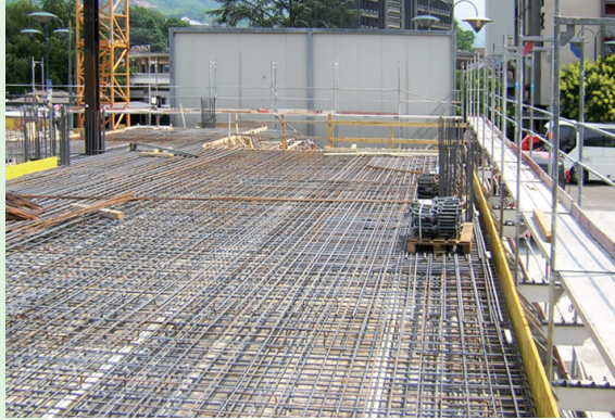
solai tipo massiccio in calcestruzzo
