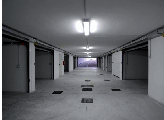
tinteggiatura piano interrato
