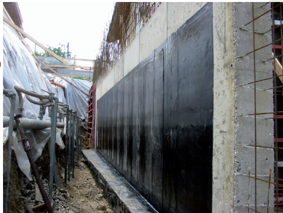
impermeabilizzazione murature interrato
