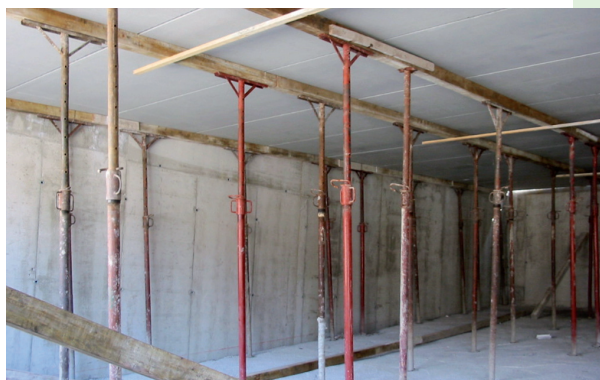
solai con lastra inferiore gettati a tutto spessore
