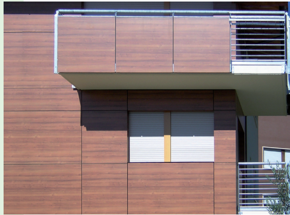
rivestimento in pannelli tipo Trespa
