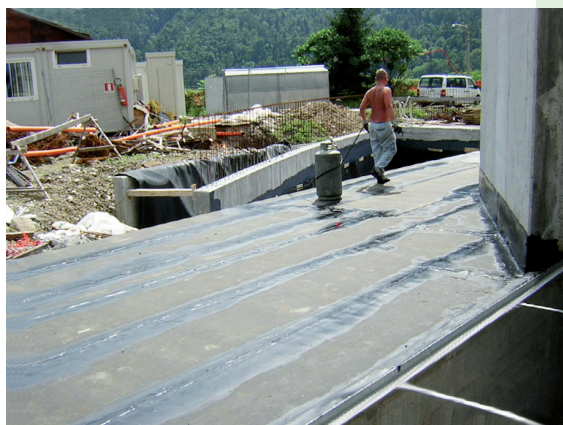
impermeabilizzazione giardini e terrazzi
