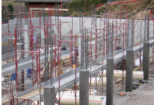
pilastri e murature perimetrali entro terra
