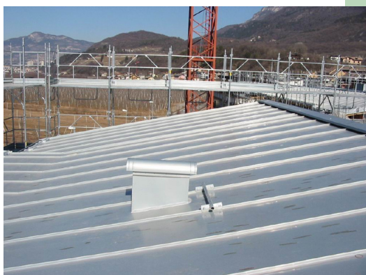
manto di copertura
