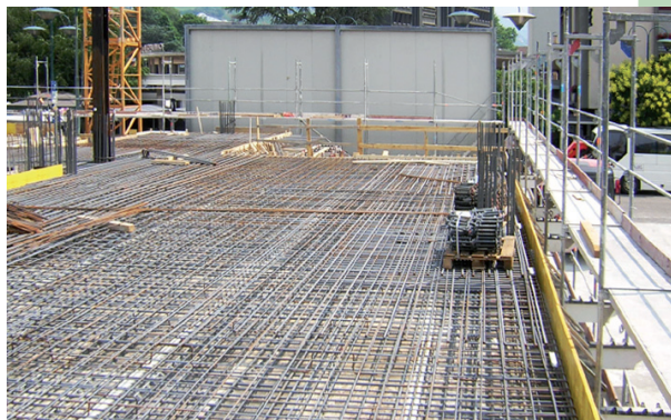
solai tipo massiccio in calcestruzzo
