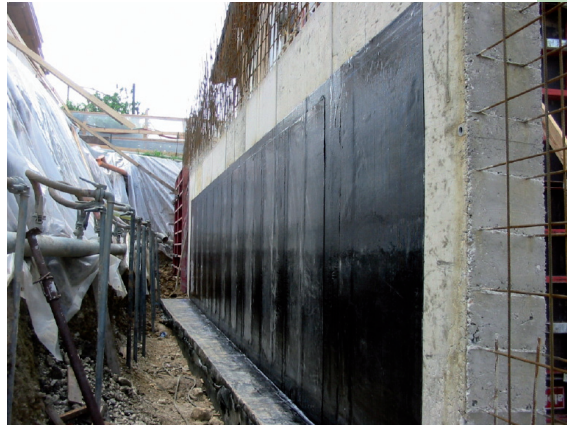
impermeabilizzazione murature perimetrali interrate
