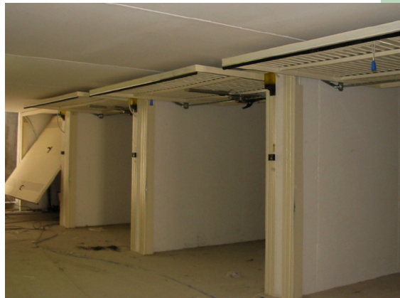
finitura murature in cls e solai autorimesse e cantine
