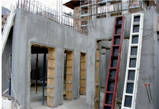
murature perimetrali entro terra
