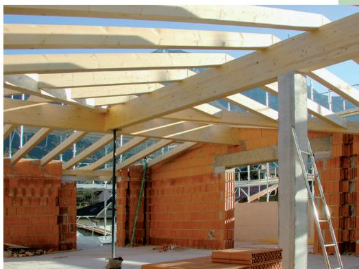
struttura portante primaria
