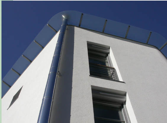
canna fumaria centrale termica
