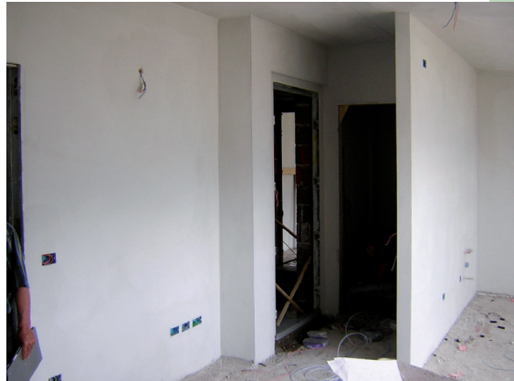
intonaci interni appartamenti
