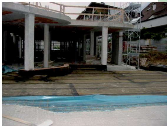
impermeabilizzazione coperture piane
