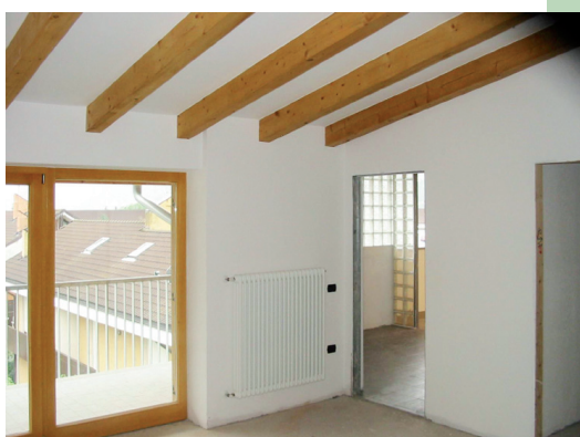
struttura portante secondaria con rivestimento interno
