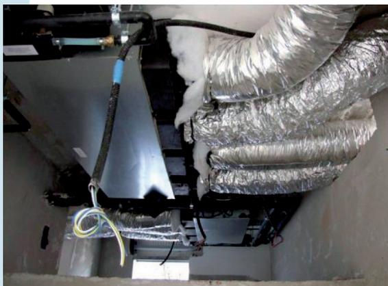
*ventilconvettore a soffitto*
