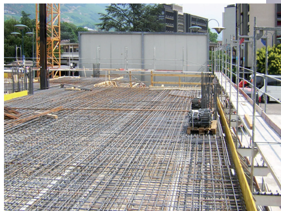
soffitto massiccio in calcestruzzo
