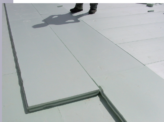
isolazione copertura
