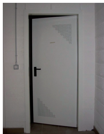
porta cantina con griglie aerazione integrate
