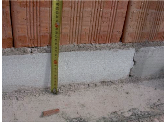
eliminazione ponti termici verticali
