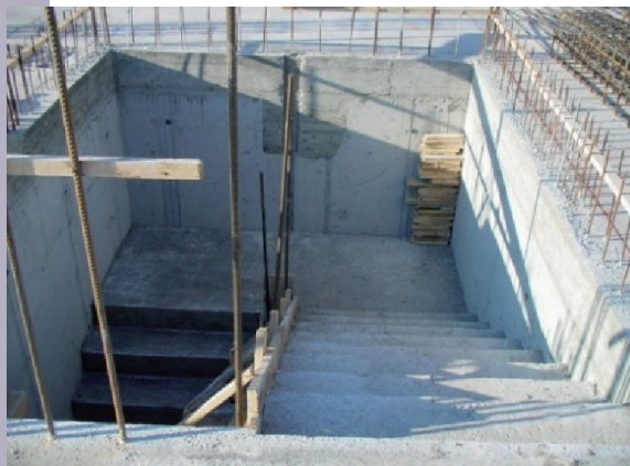
particolare scale in calcestruzzo
