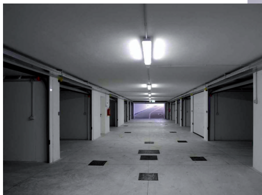
tinteggiatura interna autorimessa e cantine
