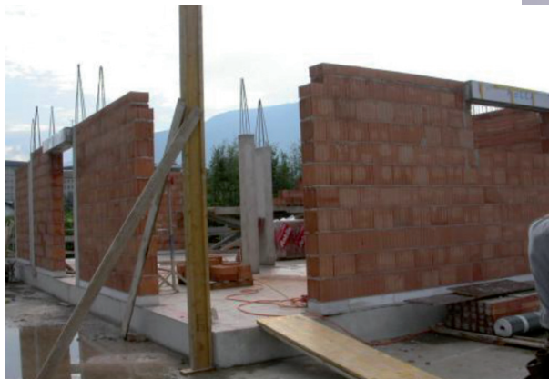
murature perimetrali in laterizio alveolato
