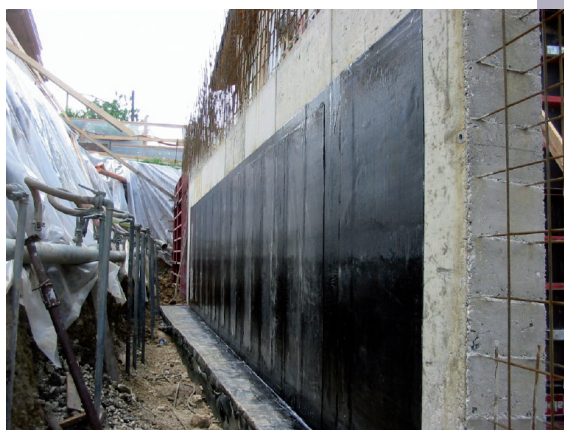
impermeabilizzazione murature entro terra
