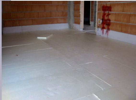
isolazione solai con sottostanti zone fredde
