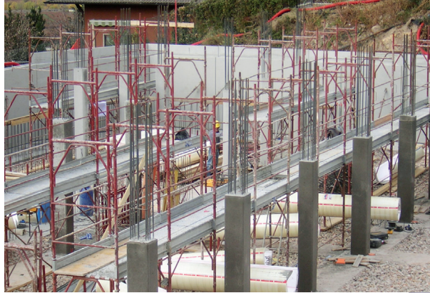
murature perimetrali entro terra e pilastri
