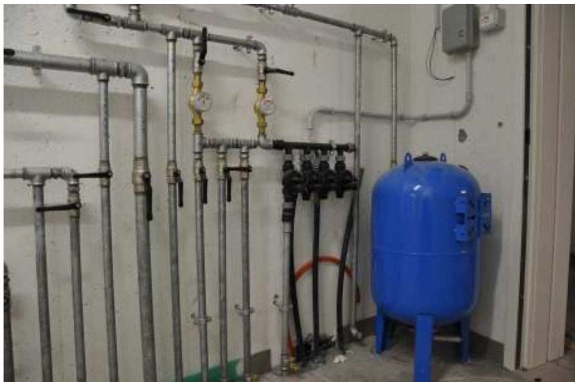
Fig.13: L'impianto di pompaggio e distribuzione dell'acqua meteorica.
