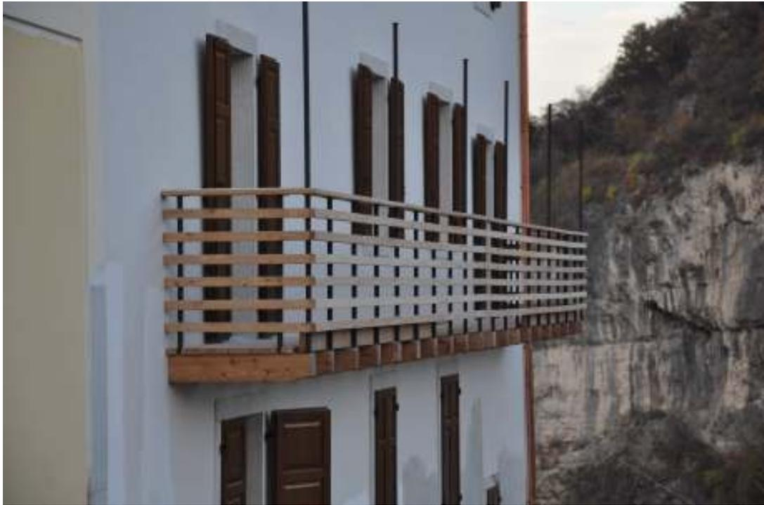
Fig.4: il ballatoio a est con medioni in larice bilama
