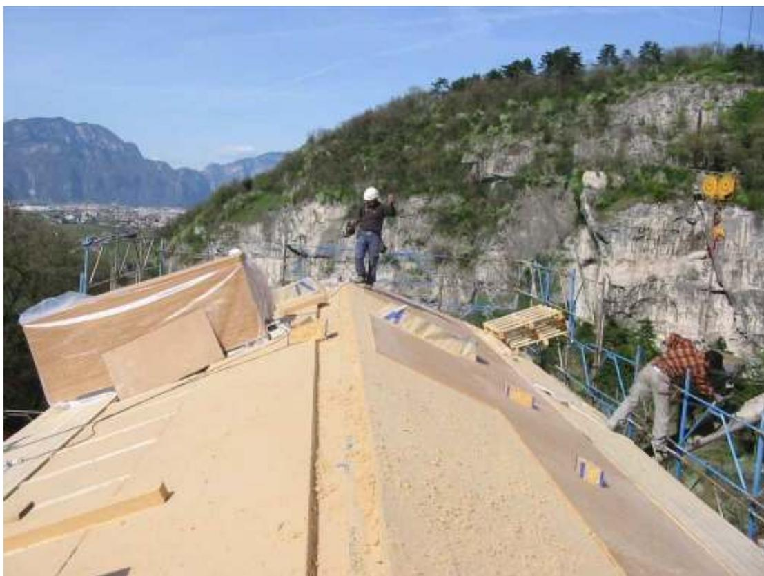
Fig.2: la posa del secondo strato di isolante
