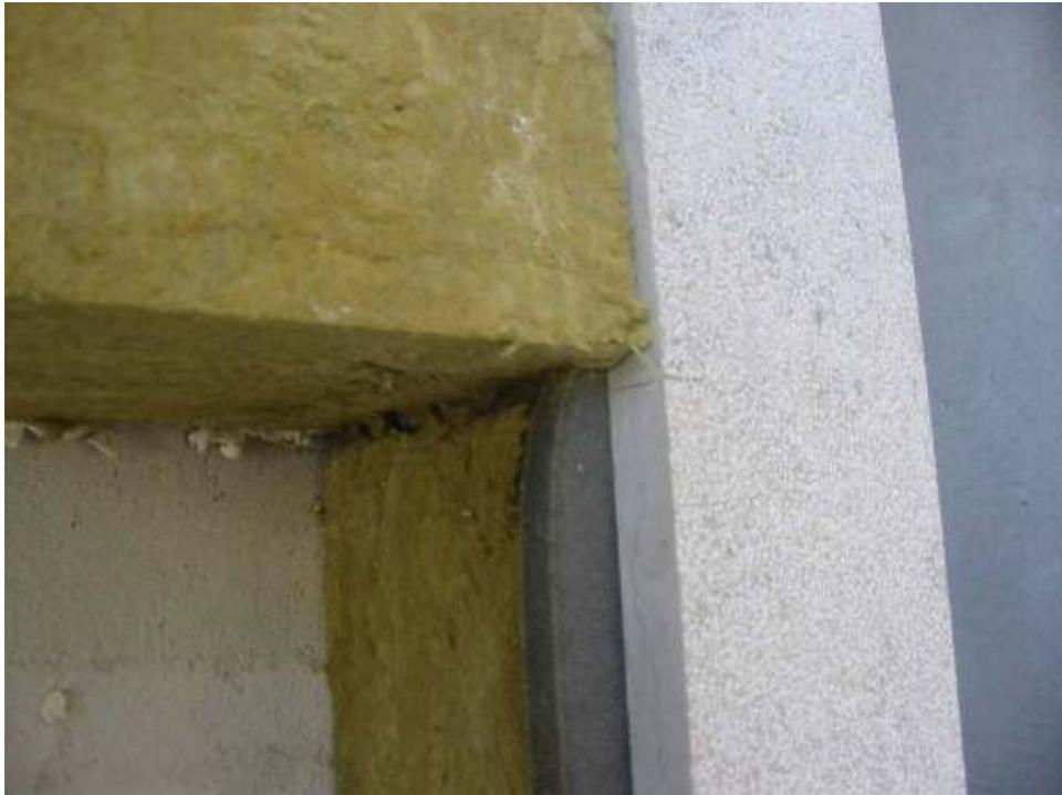
Fig.14: il particolare della posa dei pannelli in fibra all'interno delle pilastrate in pietra verdello opportunamente scavate, per evitare il ponte termico.
