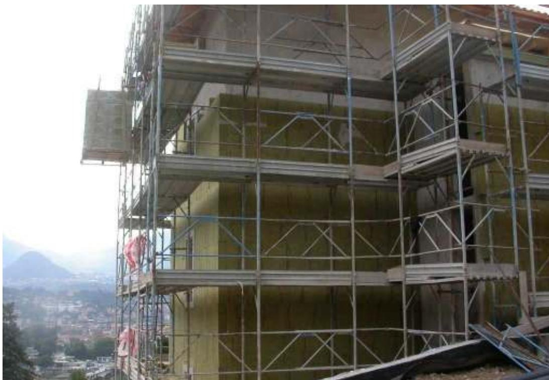
Fig.13: la posa dei pannelli in fibra minerale.
