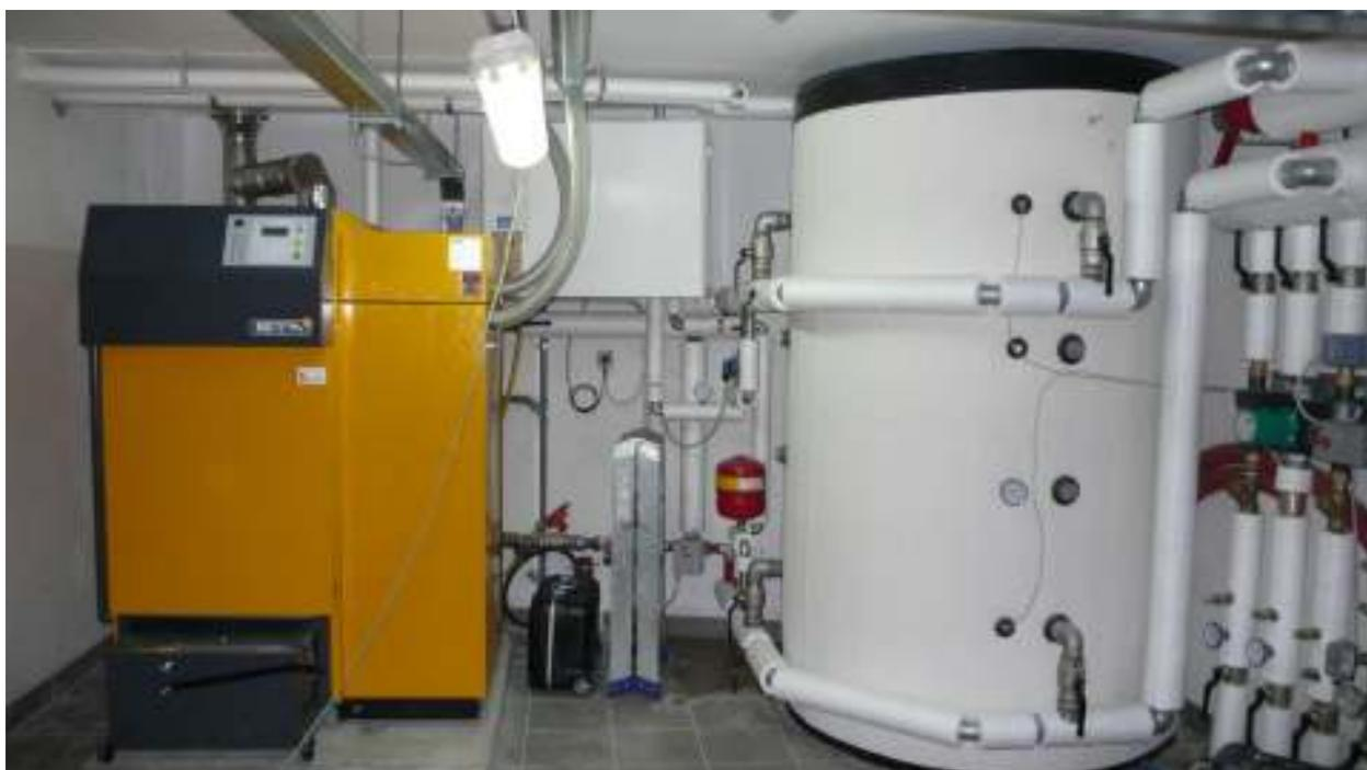
Fig.7: la centrale termica con la caldaia a pellets. Si notano sul lato dx del generatore i tubi di alimentazione del combustibile (pellets), provenienti dal deposito interrato posizionato a fianco al locale caldaia.
