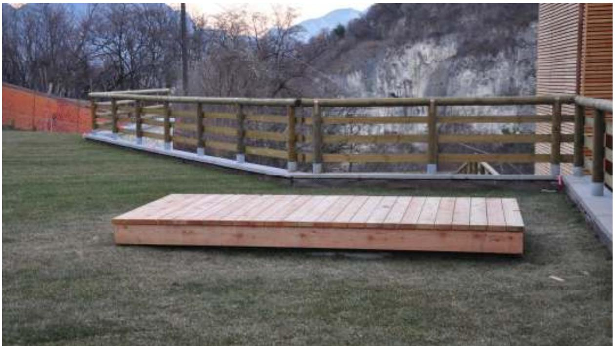
Fig.9: l'ispezione a cielo aperto del deposito pellets posta nell'area a verde comune.
