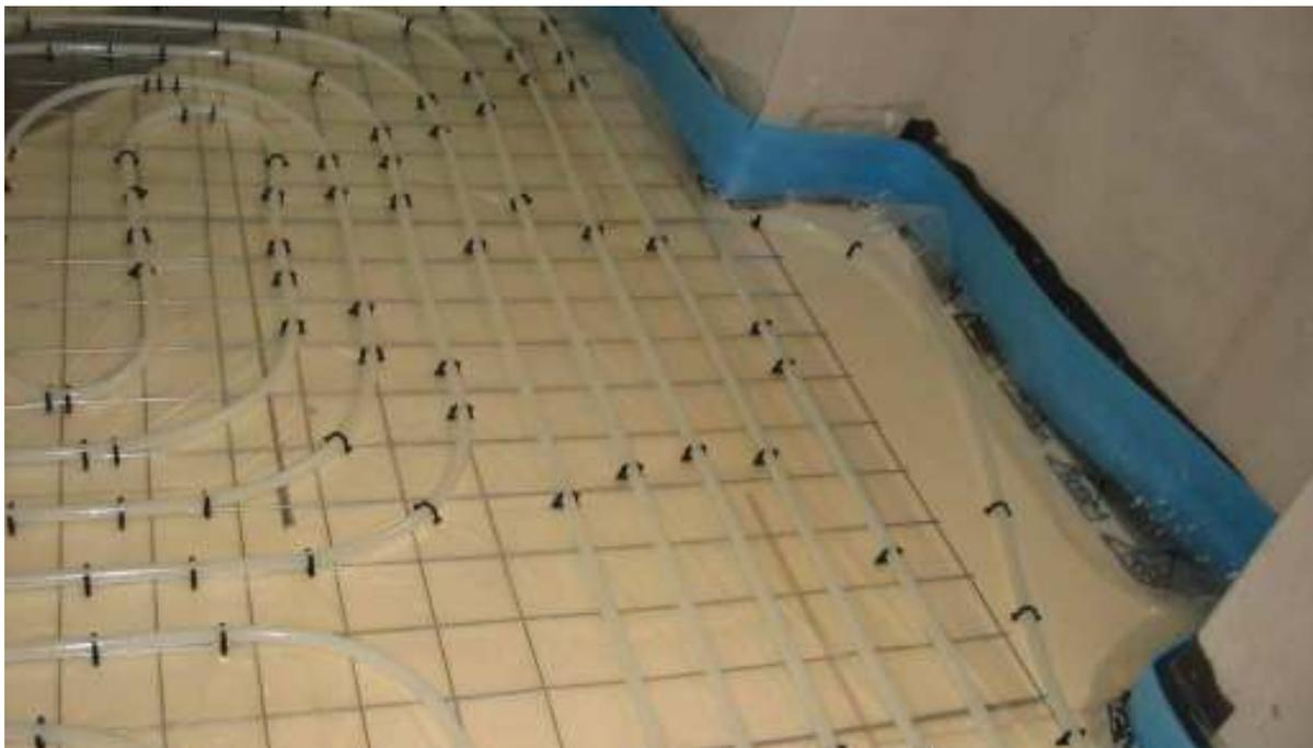
Fig.10: la posa dell'impianto a bassa temperatura a pavimento.
