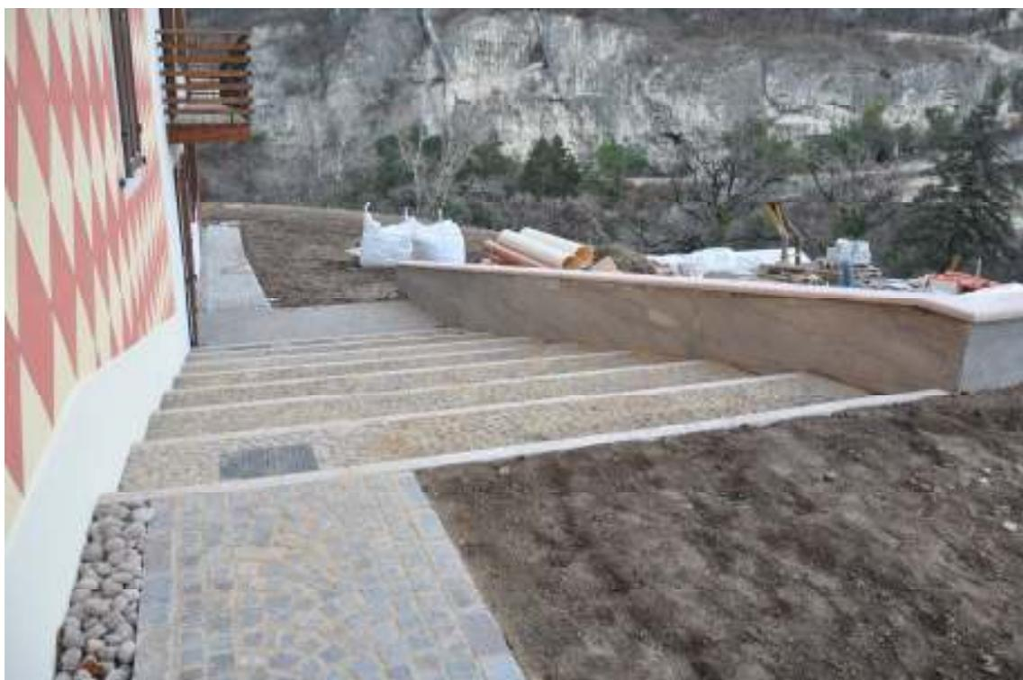
Fig.4: la pavimentazione esterna con cubetti e ciottoli di fiume lavati
