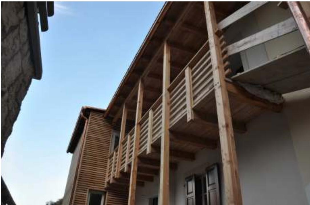
Fig.5: i ballatoi esterni sul lato est realizzati in legno di larice bilama naturale
