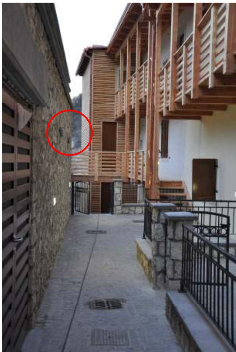
Fig.12: l'ingresso alla centrale termica e i due manicotti a parete di carico del pellets.
