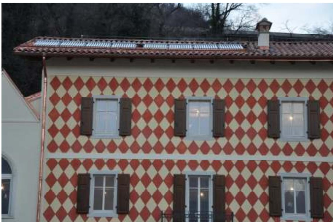
Fig.11: l'impianto di collettori solari sottovuoto integrato nella copertura.
