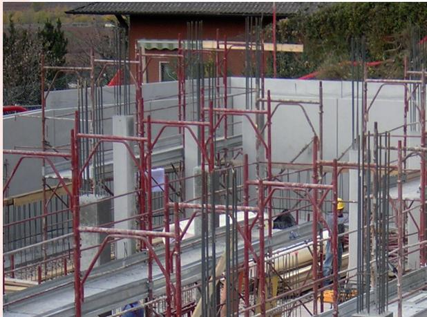
Le murature perimetrali entro terra e i pilastri dell'interrato adibito ad autorimessa così come i pilastri ed i setti dell'ampliamento dell'edificio esistente verranno realizzati in calcestruzzo di cemento "a prestazione garantita" confezionato a macchina, gettato in opera e opportunamente vibrato, con armatura metallica in acciaio B 450 C ad aderenza migliorata nelle quantità e caratteristiche come da calcoli statici.
