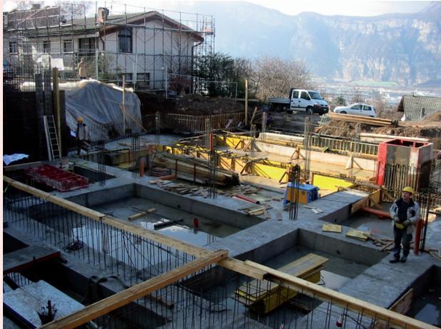
Viste le caratteristiche del terreno sul quale insistono i nuovi corpi di fabbrica dell'interrato adibito ad autorimessa e dell'ampliamento dell'edificio esistente, risultanti dalla relazioni geologica e geotecnica, le fondazioni saranno del tipo continuo a travi rovesce e a plinto o a platea in calcestruzzo di cemento "a prestazione garantita" confezionato a macchina, gettato in opera
